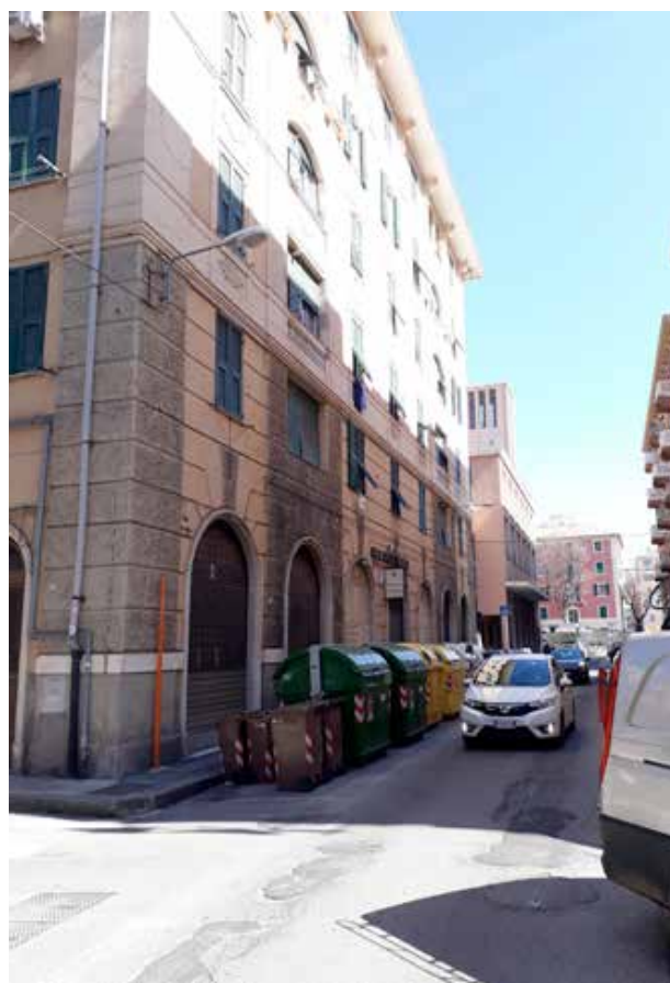
Scorcio del fronte sud e di via Fabio di Persico
