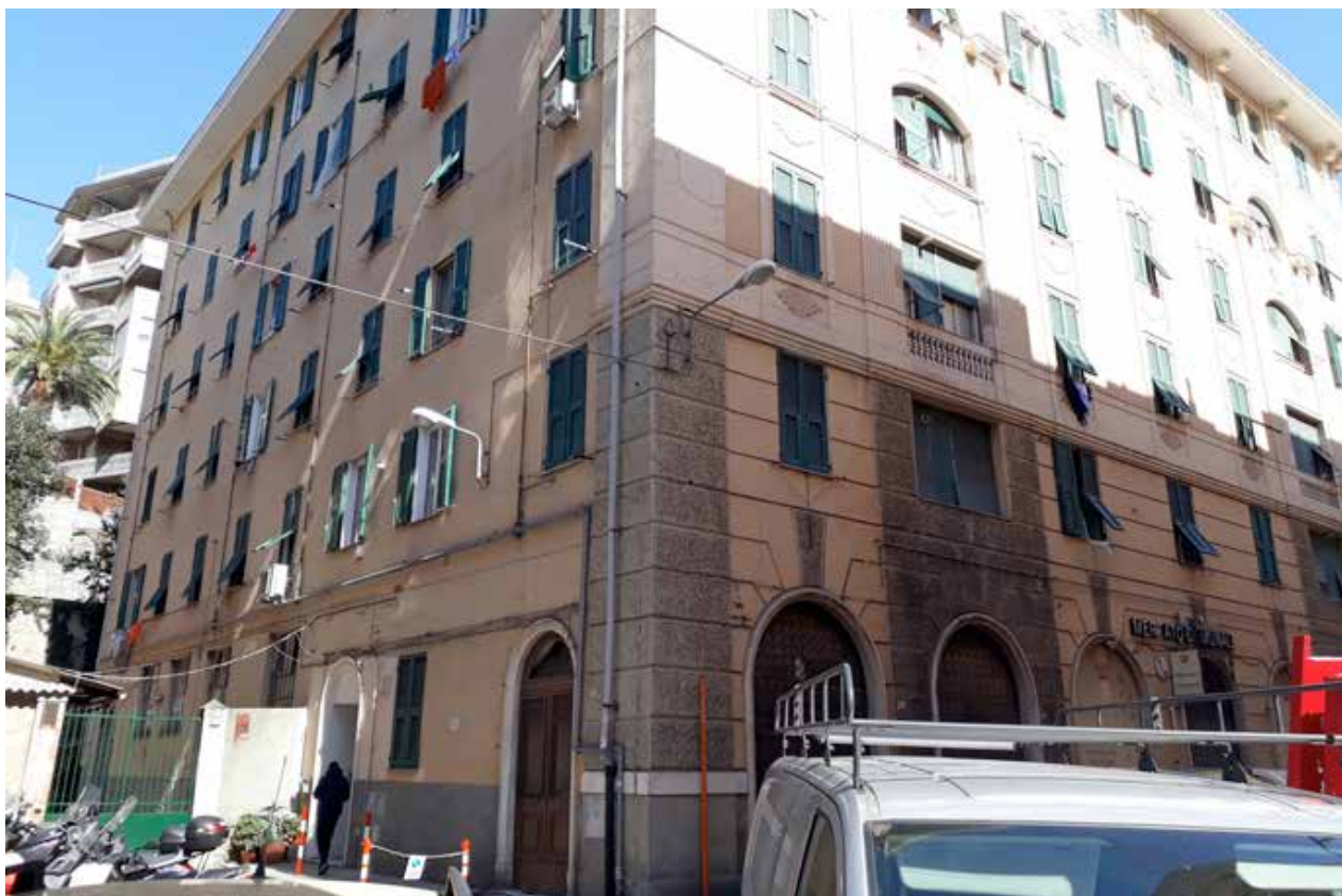
Scorcio dell'angolo sud ovest del fabbricato
