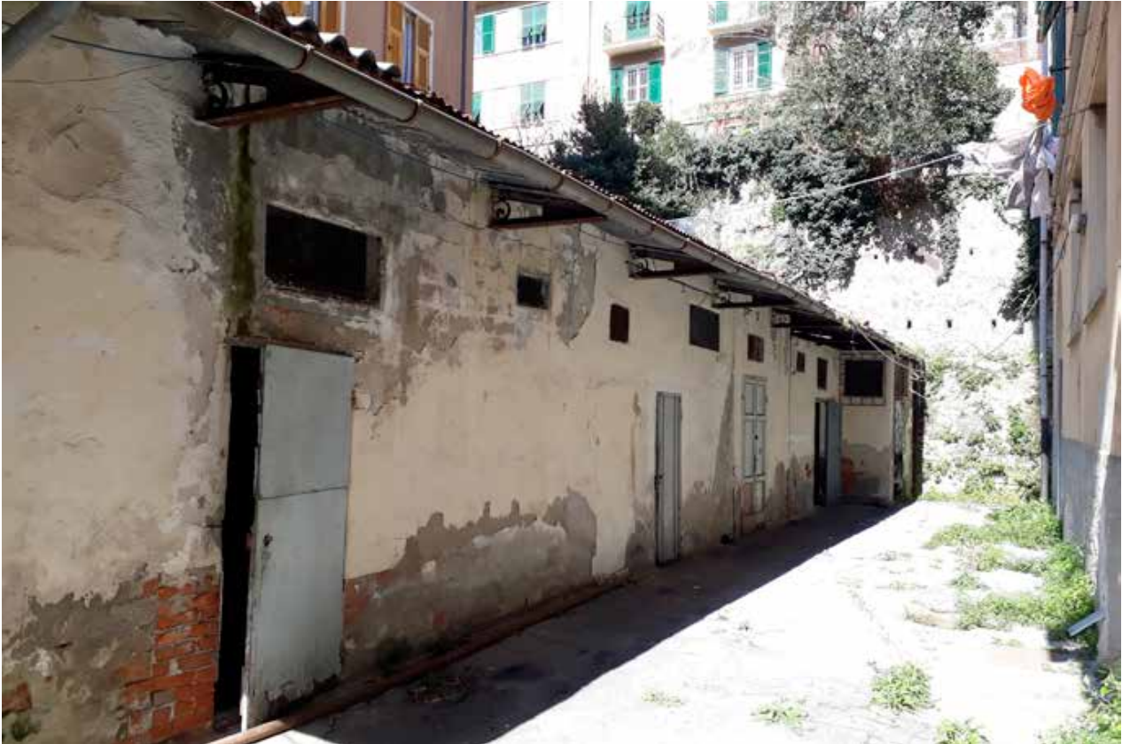
Vista degli annessi collocati sul fianco ovest
