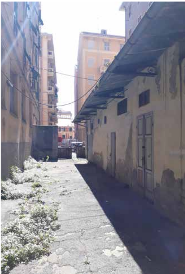
Scorcio degli annessi collocati sul fianco ovest e del corsello
